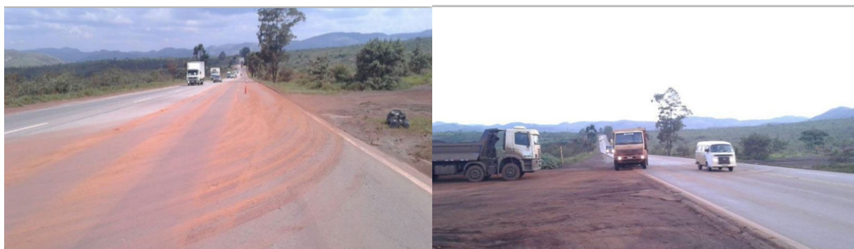
Fotos 05 e 06: Acesso à Mineradora SAFM - km 584 | Fonte: Relatório Fotográfico "Acesso Mineradoras" elaborado pela Concessionária Via 040
