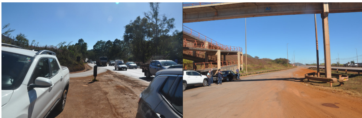
Fotos 07 e 08: Parte do pavimento coberto por minério – km 572 Fonte: GT ENGENHARIA NA BR-040
