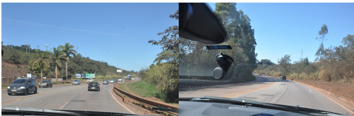
Fotos 11 e 12: A maior parte do trecho em estudo não tem acostamento Fonte: GT ENGENHARIA NA BR-040
