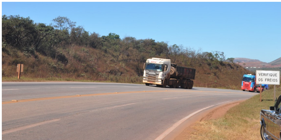
Foto 19: Curva com geometria/ topografia inadequada Fonte: GT ENGENHARIA NA BR-040
