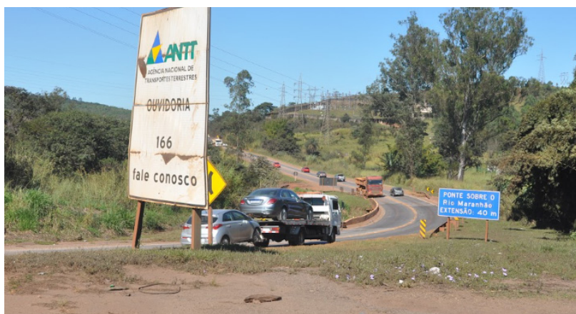
Foto 21: Estreitamento de pista em obras de arte especiais Fonte: GT ENGENHARIA NA BR-040
