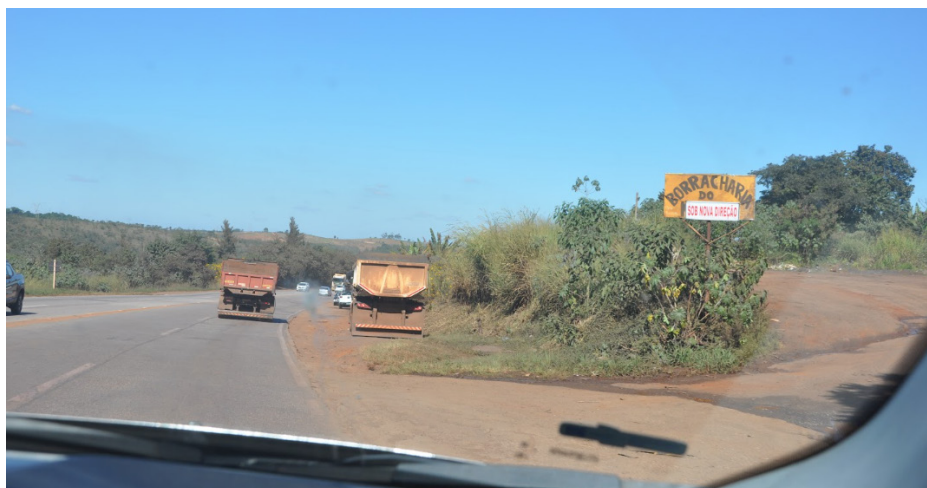
Foto 18: Acesso irregular para borracharia Fonte: GT ENGENHARIA NA BR-040
