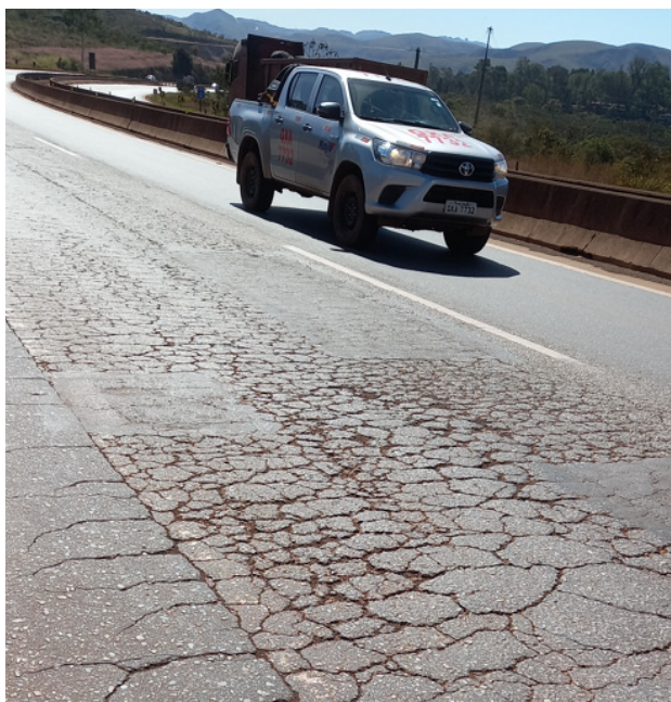
Fotos 10: Pavimento deteriorado - km 600 Fonte: GT ENGENHARIA NA BR-040
