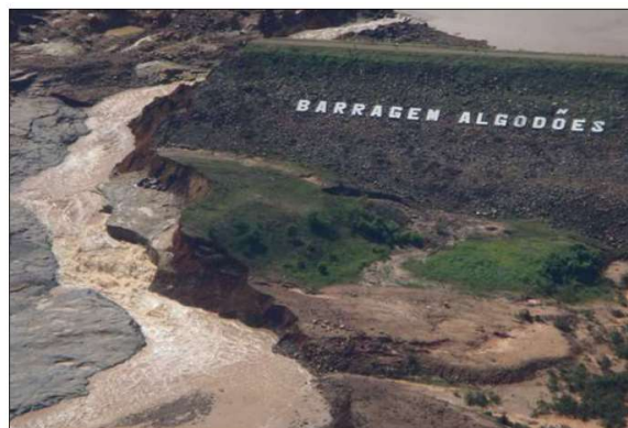
FIGURA 2 – ROMPIMENTO DA BARRAGEM DE ALGODÕES/PI.
