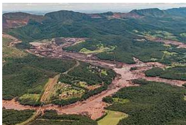
FIGURA 4 – ROMPIMENTO DA BARRAGEM DA MINA DO CÓRREGO DO FEIJÃO, BRUMADINHO/MG
