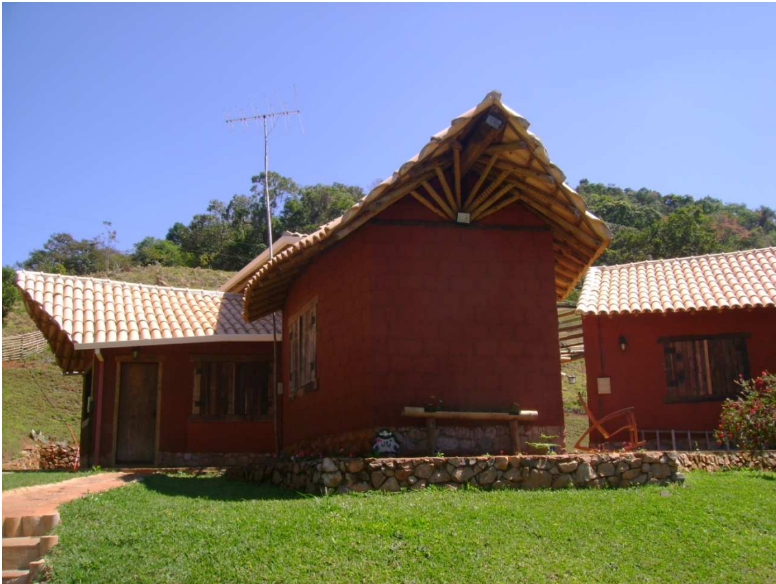
Figura 2 – Vista de um dos módulos da Casa Estrela com paredes de adobe pintadas com tinta à base de terra, pigmento mineral e resina natural de linhaça.
