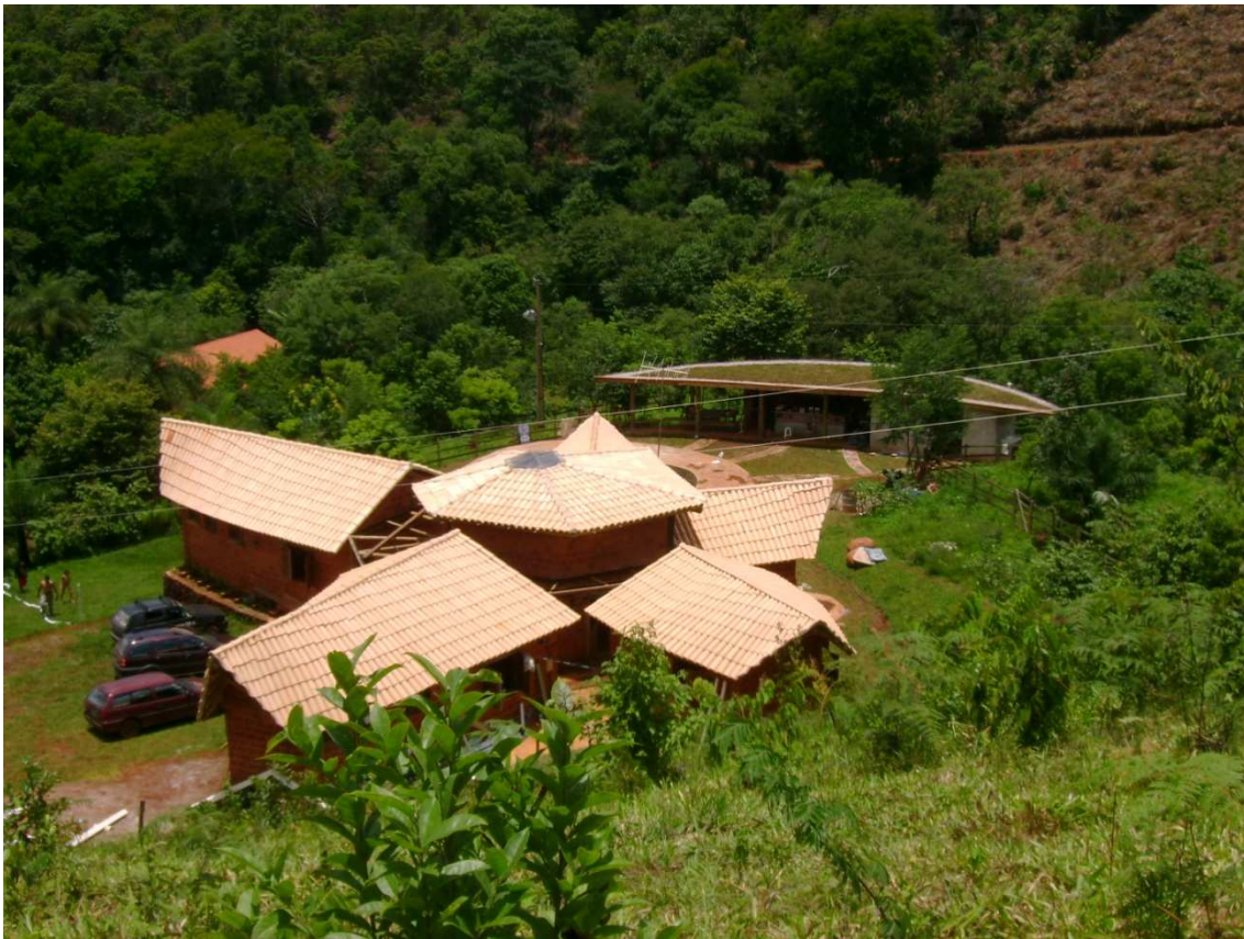
Figura 1 – Vista geral da Casa Estrela e da Lua (área de lazer) construídos com adobes fabricados com solo oriundo do movimento terra.
